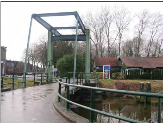
Foto 3.23 De kantelbrug over het Apeldoorns Kanaal.
